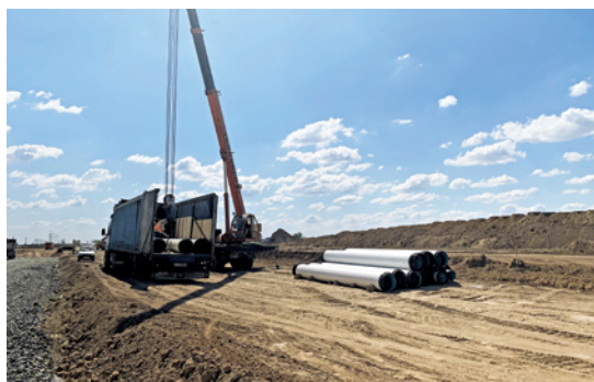
Строительство магистрали по ул. Карбышева, г. Волжский, Волгоградская обл.
