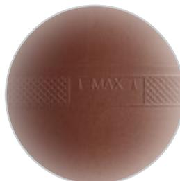
Отметка глубины вставки трубы
