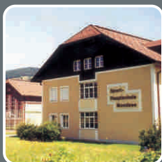
Здание школы (Австрия) Ввод в действие: 1989 Скважины 3000 м. Источник тепла: рассол
