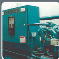
Мойка автомобилей (Чехия) Тепловая мощность: 140 кВт Источник тепла: вода
