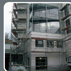
Здание церкви (Германия) Тепловая мощность: 2x113,7 кВт Источник тепла: вода
