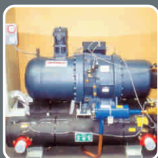
Фабричное здание (Польша) Тепловая мощность: 233 кВт Источник тепла: вода
