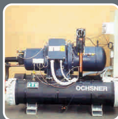
2 Жилых дома и 1 школа Сломники (Польша) Тепловая мощность: 280 кВт Источник тепла: вода
