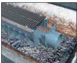
Герметизация соединений
