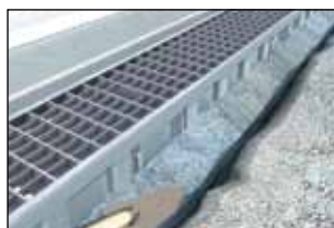
Бетонирование и укладка покрытия
