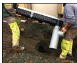
Установка песколовки
