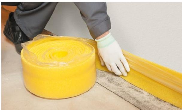
Лента наклеивается на нижнюю часть выровненной и оштукатуренной стены. Клеят ленту по всему периметру помещения, сплошным полотном, без пропусков.
