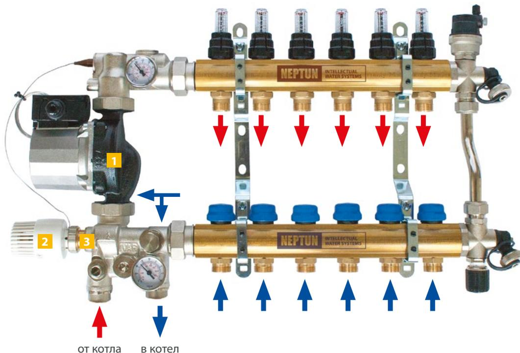
Циркуляционный насос 1 обеспечивает циркуляцию теплоносителя через петли теплого пола. При остывании теплоносителя ниже настроечной температуры термоголовки 2, смесительный клапан 3 открывается и обеспечивает подпитку вторичного контура теплоносителем из первичного контура с подмесом теплоносителя из подающего коллектора вторичного контура.
