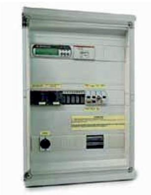
Предназначена для автоматического управления работой вентиляционного агрегата: регулирования тепловой мощности калорифера, защиты от перегрева и других критических условий работы.
