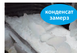
Без электрического нагревателя поддона
