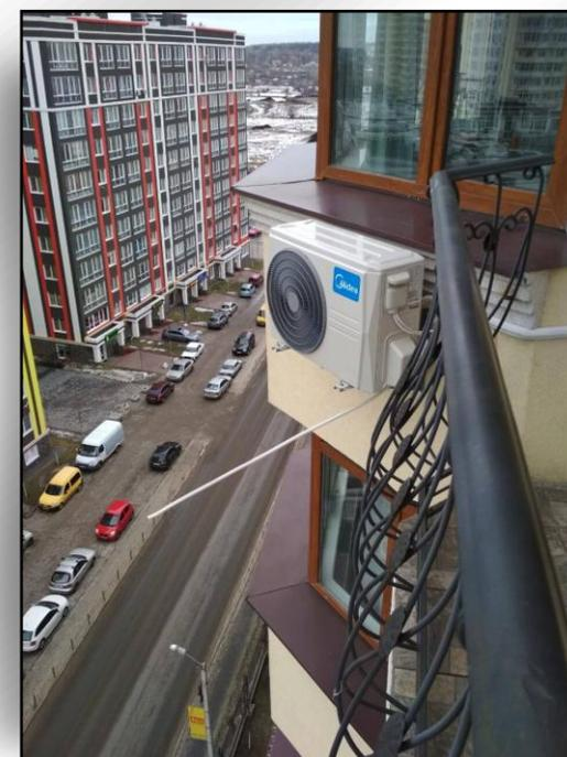
2) **На стену.** Единственное отличие от обычного монтажа в удобстве прикручивания кронштейнов, на которых закрепляется внешний блок сплит системы. Неплохое решение для открытых балконов, где у хозяев нет на стенах шкафчиков. Однако такое расположение не очень подойдет застекленным балконам, т.к. при работе сплит-системы окна балкона придется держать постоянно открытыми, плюс возникает проблема с отведением воды после оттайки блока в зимнее время.
