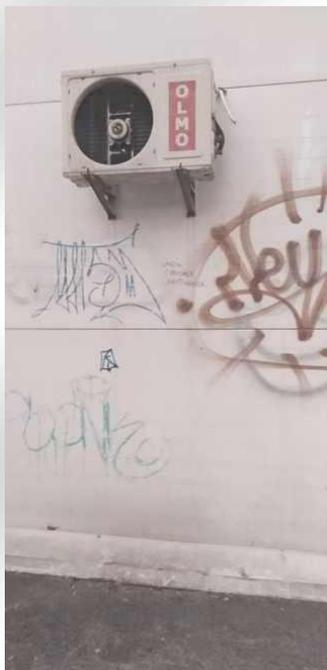
Если вы живете на верхних этажах, то наружный блок можно поставить на крышу. Но учтите, что разница между внутренним и внешним блоками по высоте не должна превышать 5–20 метров (в зависимости от марки кондиционера и модели). Так же не следует забывать про маслоподъемные петли, которые обеспечивают возврат масла в компрессор, без них велика вероятность наступления масляного голодания компрессора и как следствие – его заклинивание.
