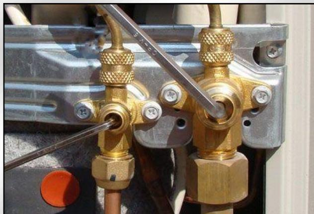
По окончании, заглушки необходимо затянуть с таким же усилием как и гайки, иначе при работе на обогрев произойдет утечка, т.к. резиновое кольцо в вентиле будет не в состоянии удержать давление около 30 атмосфер (бар).
