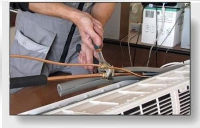
Усилие при затяжке гаек должно соответствовать данным приведенным в таблице 2
