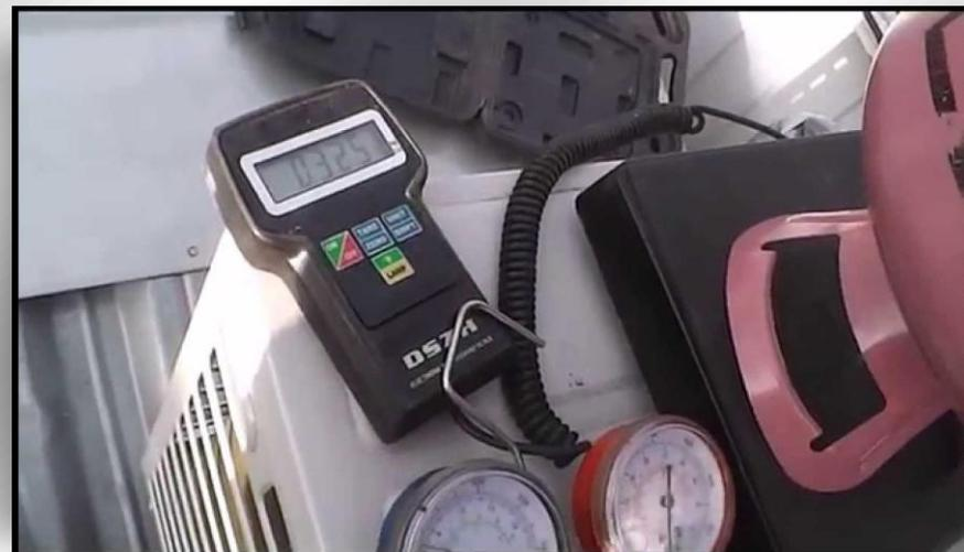
Для этого, на вентилях откручивают разводным ключом заглушки и с помощью шестигранных (имбусовых) ключей открыть против часовой стрелки сначала жидкостной, а потом газовый вентили, контролируя повышение давления в контуре сплит-системы по манометру.
