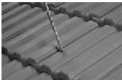
Шаг 1. Сверление отверстия в кровле
