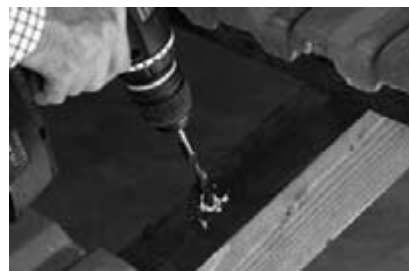
Шаг 2. Сверление отверстия в стропиле
