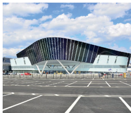
Конгресс-Холл, Екатеринбург-ЭКСПО, г. Екатеринбург
