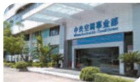
Производственная база в г. Шунде (Shunde)
