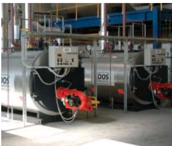
Два паровых котла высокого давления UNIVERSAL U-HD для производства насыщенного пара
