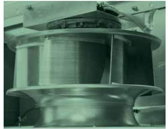
ЕС-вентилятор с плавным электронным регулированием частоты вращения
