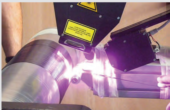
Сварка лент из углеродных волокон. (Фото: MF-Tech, Франция, www.mftech.fr )
