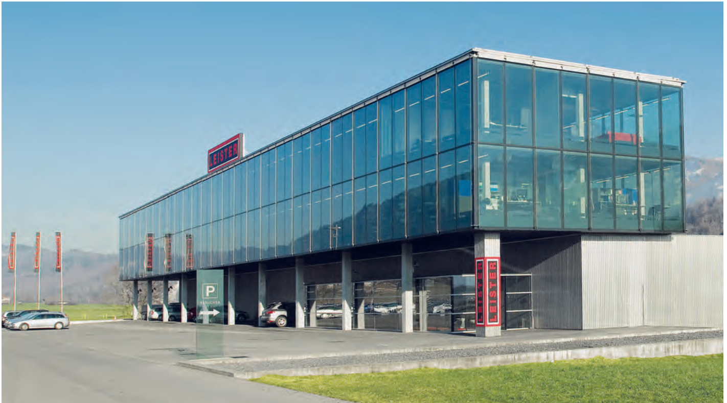
Leister Technologies AG, корпоративный центр, Кегисвиль, Швейцария
