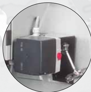
Электрический сервопривод для регулировки воздуха
