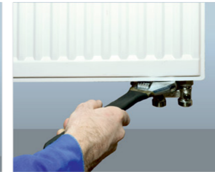
(2) Привинтить узел нижнего подключения радиатора
