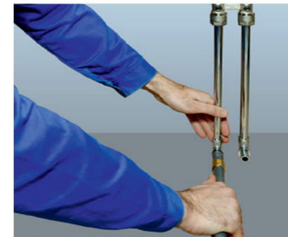
(7) Расширенный конец трубы надеть на штуцер трубки и надвинуть гильзу (см стр. 15-16)
