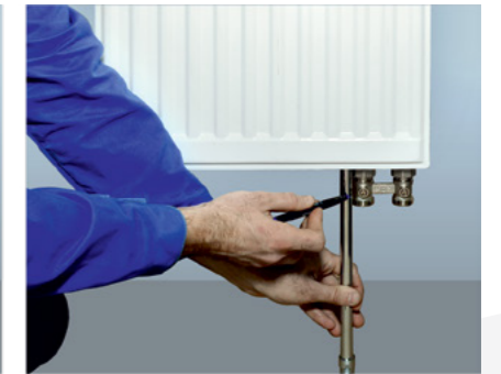
(3) Отметить нужную длину трубки для при-соединения радиатора
