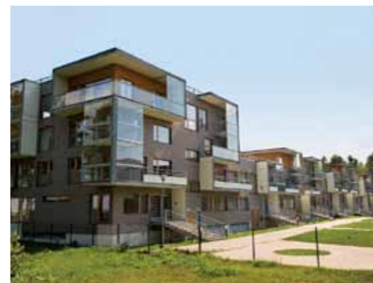
Жилой комплекс Таллин, Эстония
