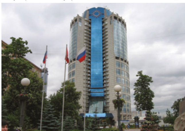
ГУП «МОСВОДОСТОК» Москва, 440 кВт
