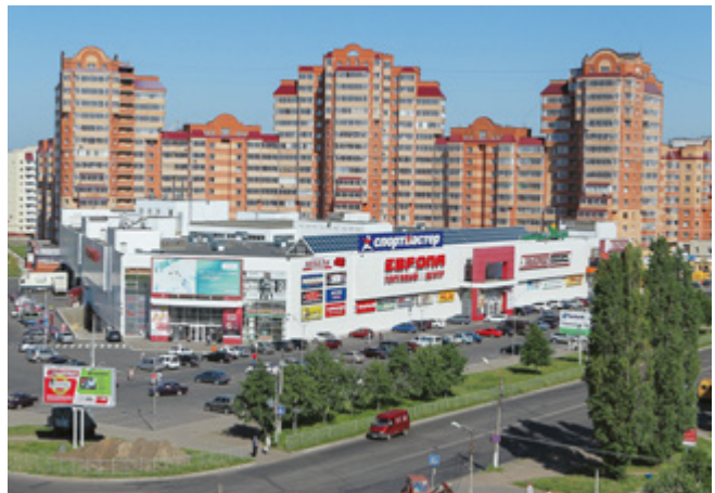
ТОРГОВЫЙ ЦЕНТР «ЕВРОПА 26» Железногорск, 320 квТ
