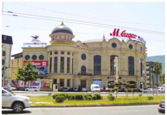
ТОРГОВЫЙ ЦЕНТР «МИРКАТО» Махачкала, 590 квТ
