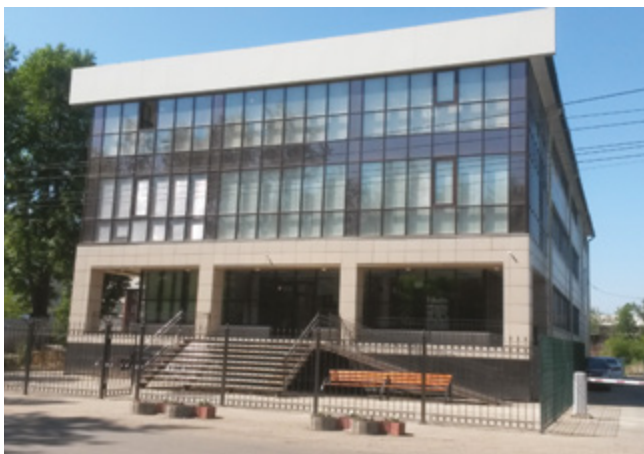
КОЛ-ЦЕНТР «ТЕЛЕ2» Иркутск, 300 квТ
