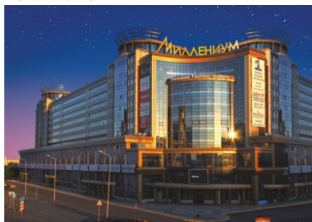
ТОРГОВЫЙ ЦЕНТР «МИЛЛЕНИУМ» Омск, 410 кВт
