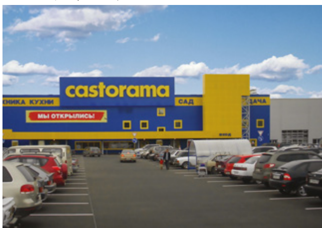
ГИПЕРМАРКЕТ СТРОИТЕЛЬНЫХ ТОВАРОВ «КАСТОРАМА» Уфа, 1 МВт
