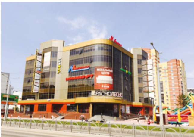
ТОРГОВЫЙ ЦЕНТР «КРАСНОЛЕСЬЕ» Екатеринбург, 700 квТ
