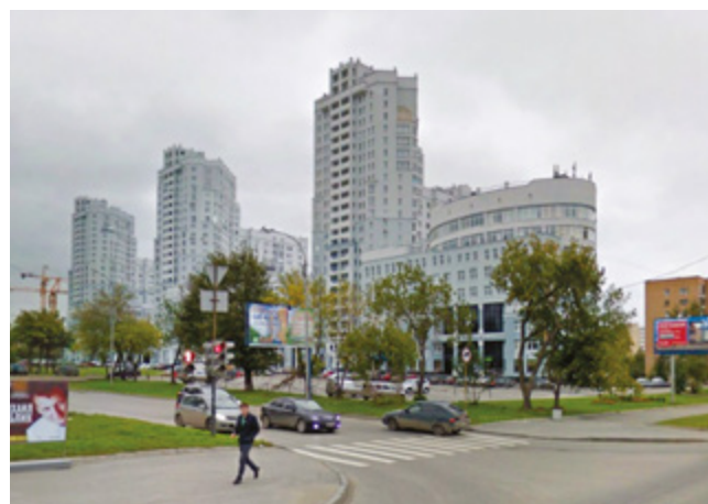
БИЗНЕС-ЦЕНТР «ТАТИЩЕВСКИЙ» Екатеринбург, 500 кВт
