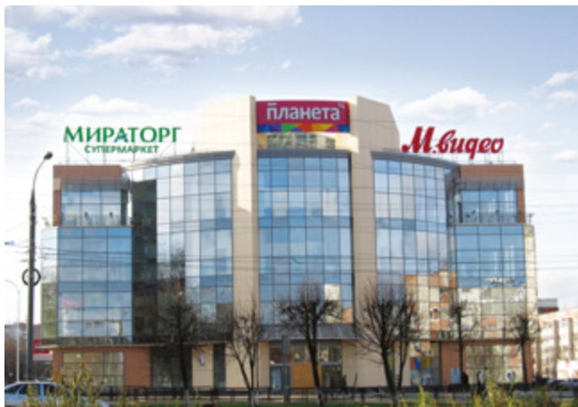
ТОРГОВЫЙ ЦЕНТР «ПЛАНЕТА» Йошкар-Ола, 836 квТ
