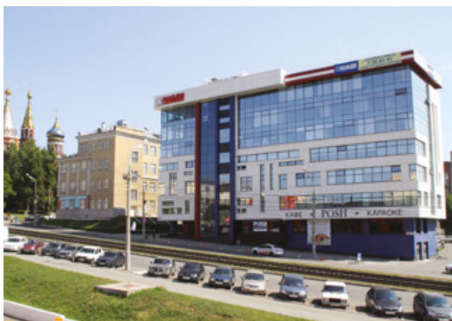
БИЗНЕС-ЦЕНТР «НАЙДИ» Ижевск, 498 кВт
