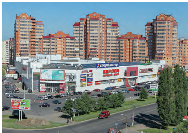
ТОРГОВЫЙ ЦЕНТР «ЕВРОПА 26» Железногорск, 320 квТ
