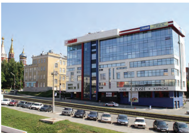
БИЗНЕС-ЦЕНТР «НАЙДИ» Ижевск, 498 квТ
