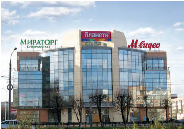
ТОРГОВЫЙ ЦЕНТР «ПЛАНЕТА» Йошкар-Ола, 836 квТ
