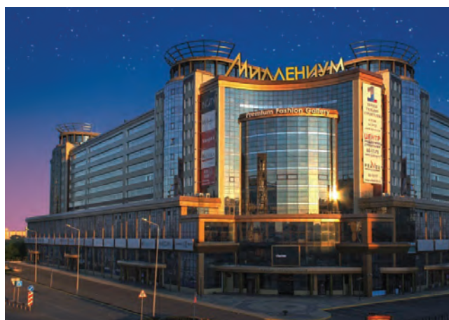
ТОРГОВЫЙ ЦЕНТР «МИЛЛЕНИУМ» Омск, 410 квТ
