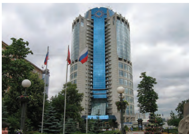
ГУП «МОСВОДОСТОК» Москва, 440 кВт
