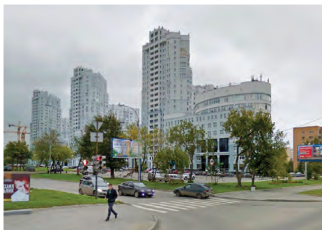
БИЗНЕС-ЦЕНТР «ТАТИЩЕВСКИЙ» Екатеринбург, 500 квТ
