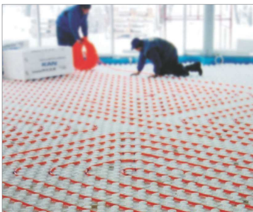
Напольное отопление, выполненное мокрым методом - греющие трубы замоноличены в полу
