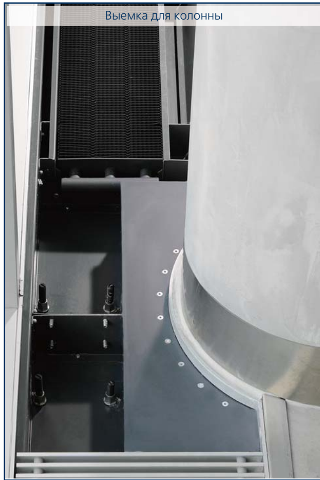
Подача приточного воздуха через герметичный фальшпол и фильтр. Дополнительно обогрев конвектором
