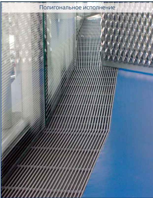
Подача воздуха через патрубки, возможность направления приточного воздуха через конвектор, конструкция канала под углом
