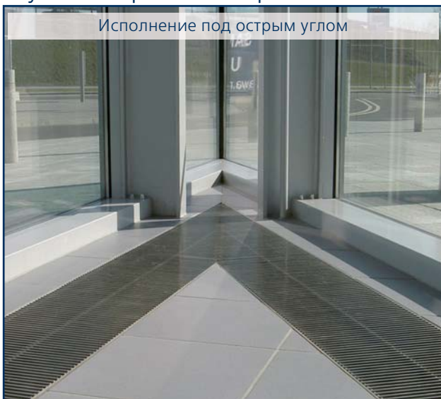
Пример соединения теплообменников
