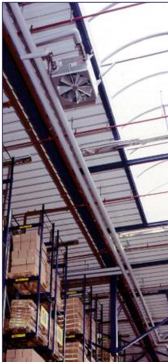
Теплообменник из оцинкованной стали, поперечноточный
