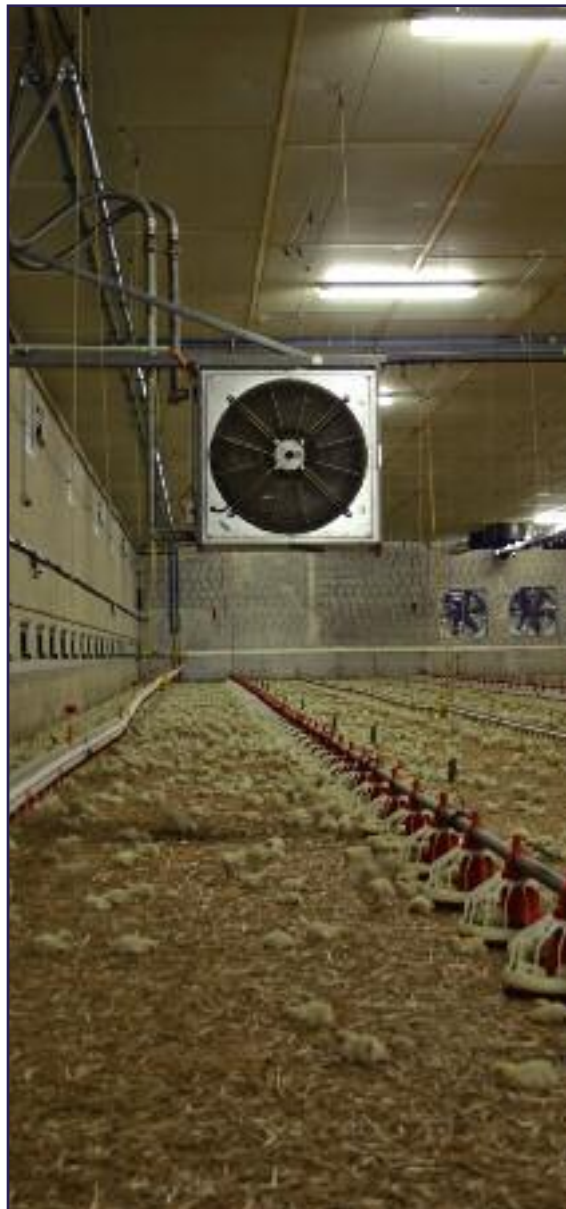
Тепловентилятор Agrar TOP, настенный монтаж
