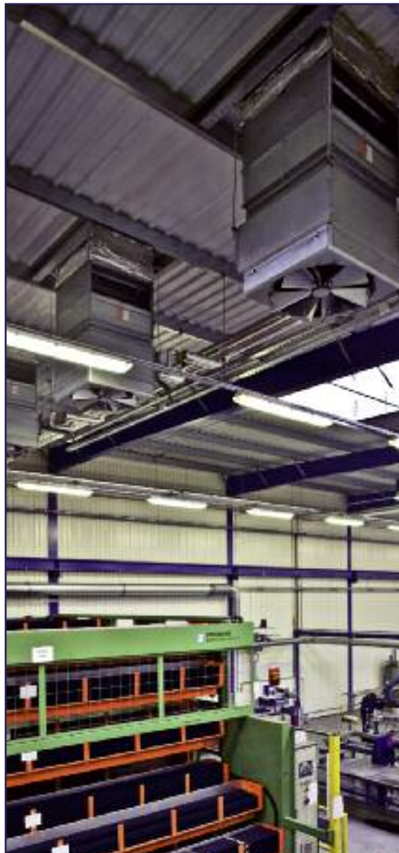
Пример: Потолочный монтаж, режим работы «Смешанный воздух», с воздухораспределителем KaMAX Пример: Настенный монтаж, режим работы «Смешанный воздух»
