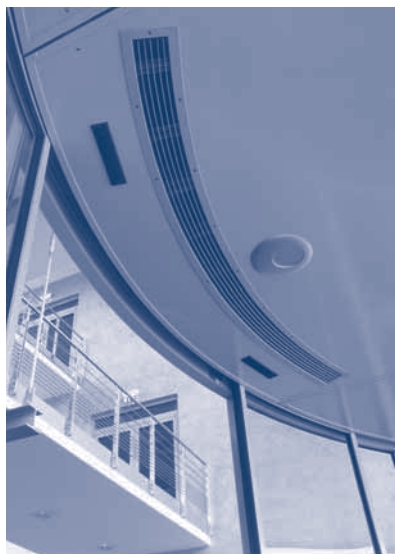
Монтаж за подвесным потолком с закругленной воздуховыпускной решеткой (специальное исполнение)
