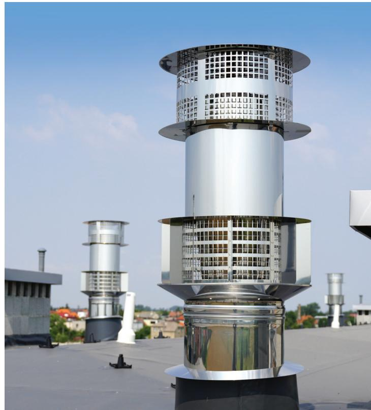
> удаление дымовых газов и одновременная подача воздуха для работы индивидуальных приборов отопления может быть обеспечено дымоходными системами компании Jeremias - CLV или LAS. Использование коллективных систем предотвращает ряд угроз, влияющих на правильную работу котла, например:
