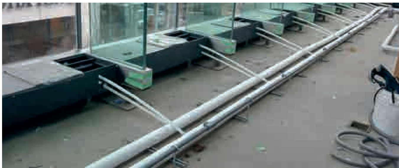
Clima Canal: Монтаж
