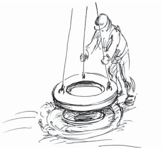
Рис. 5.4. Установка плиты перекрытия
