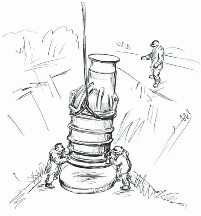
Рис. 5.2. Установка колодца
