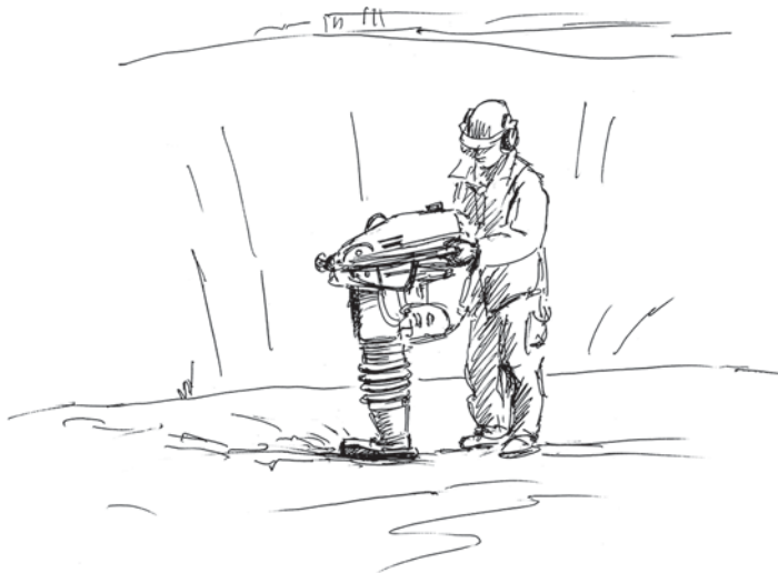
Рис. 5.1. Уплотнение грунта основания траншеи
