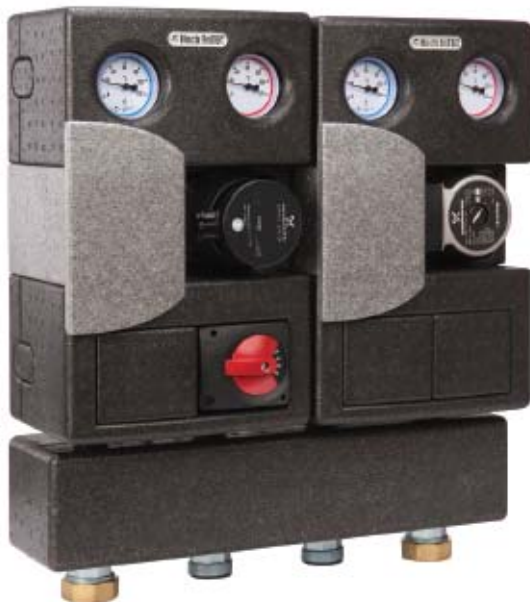
Внешний вид распределительной системы серии ECO 2 DN25
