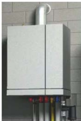
Магнитный сепаратор шлама SafeCleaner, установленный под котлом
