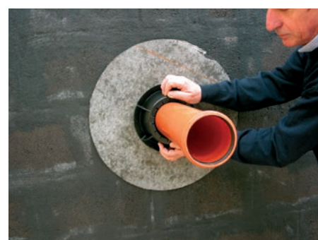
6. Затянуть фиксирующую гайку
