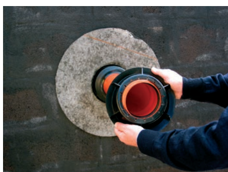
4. Установить фиксирующую гайку
