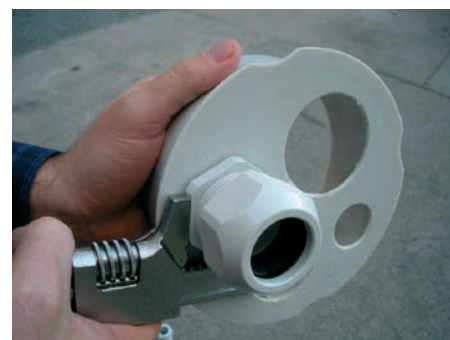
3. Установить и зафиксировать кабельные вводы.
