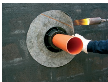
5. Приварить мембрану к битумному покрытию стены
