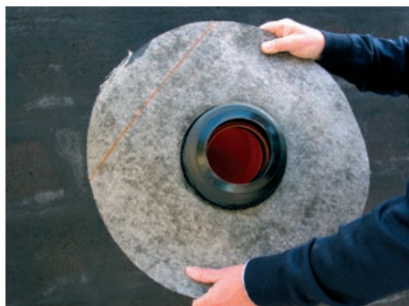
2. Надеть гидроизоляционную мембрану
