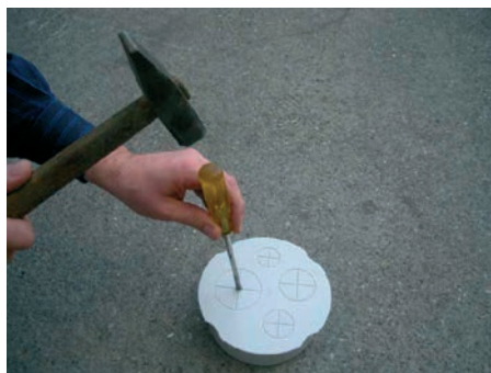
2. В монтажном элементе подготовить отверстия нужного диаметра
