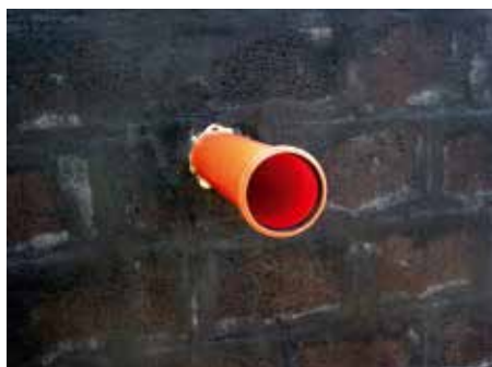
1. Труба проведена через стену с битумным покрытием.
