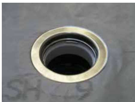
10. Зажать фильтрующий слой фиксирующим фланцем элемента HL350.0
