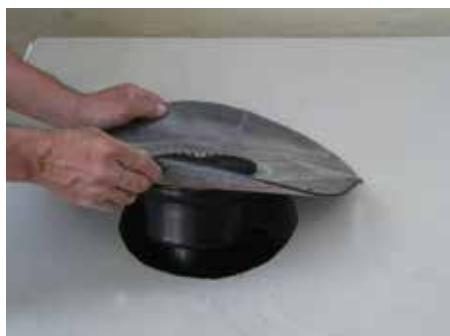
1. Прodelать отверстие Ø 255мм, закрепить воронку HL62H
