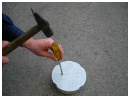
2. В монтажном элементе подготовить отверстия нужного диаметра
