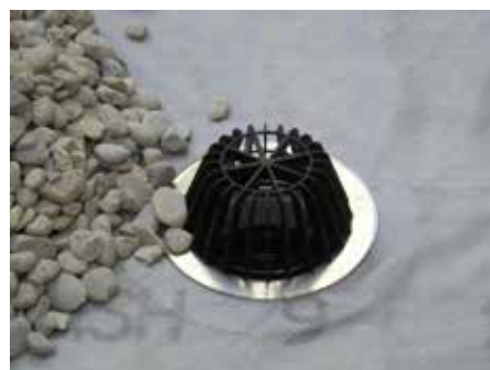
11. Установить листоуловитель, выполнить засыпку гравием (фракция: 20+40 мм)
