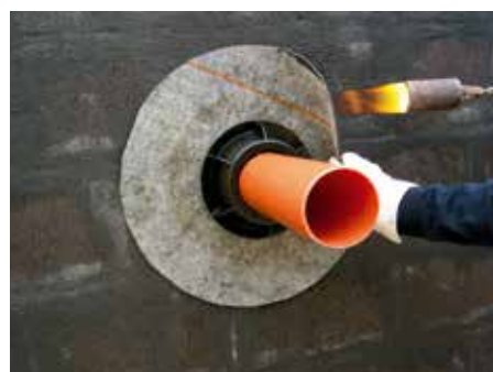
5. Приварить мембрану к битумному покрытию стены
