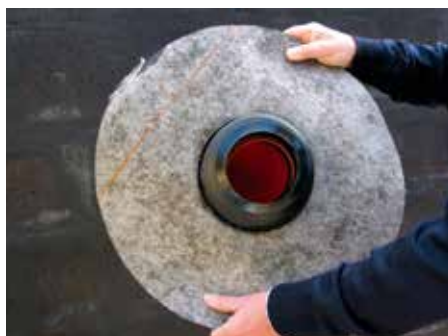
2. Надеть гидроизоляционную мембрану
