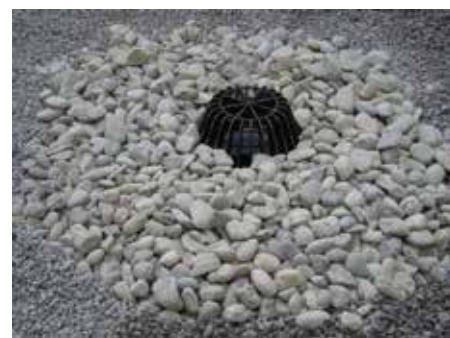
12. Засыпать гравием остальную поверхность кровли
