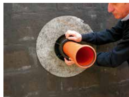
6. Затянуть фиксирующую гайку
