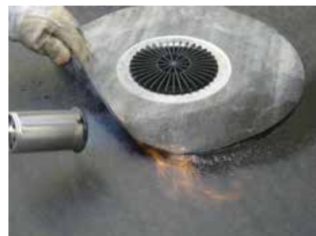
3. Приварить полимербитумное полотно воронки
