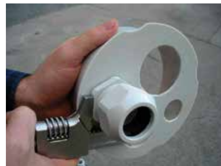
3. Установить и зафиксировать кабельные вводы.
