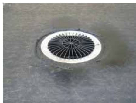
5. Так должна выглядеть воронка после укладки гидроизоляции
