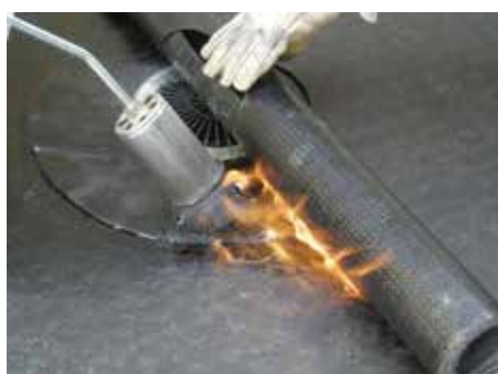
4. Наклеить 2-й слой гидроизоляции (до обжимного фланца)
