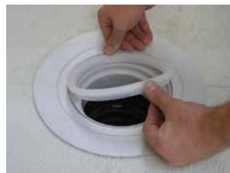
9. Убедиться в правильности установки прозрачного пластикового кольца
