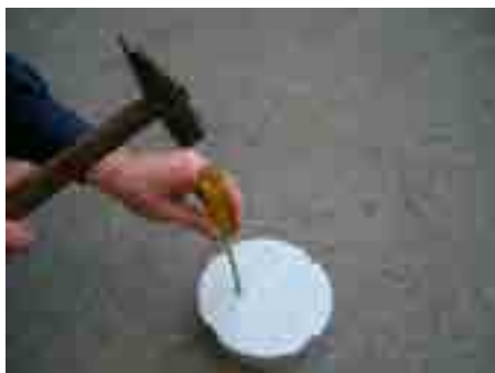
2. В монтажном элементе подготовить отверстия нужного диаметра
