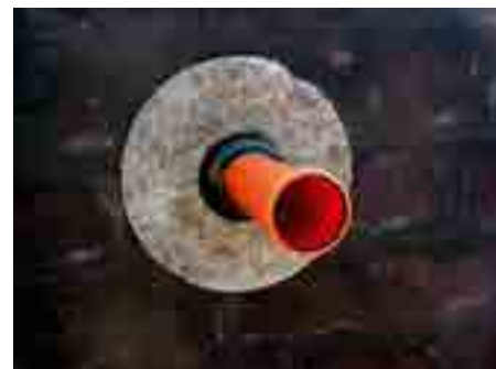
3. Придвинуть вплотную к стене
