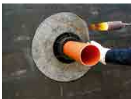
5. Приварить мембрану к битумному покрытию стены
