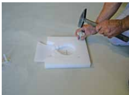
4. Прикрепить с помощью дюбелей нижнюю часть комплекта
