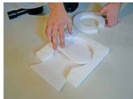
6. При необходимости увеличить высоту установки трапа
