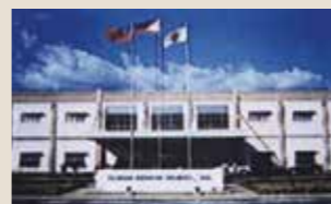
Hitachi Air Conditioning, Филиппины
