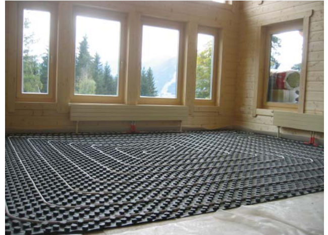
Панельное напольное отопление с системными элементами в виде мата с бобышками
