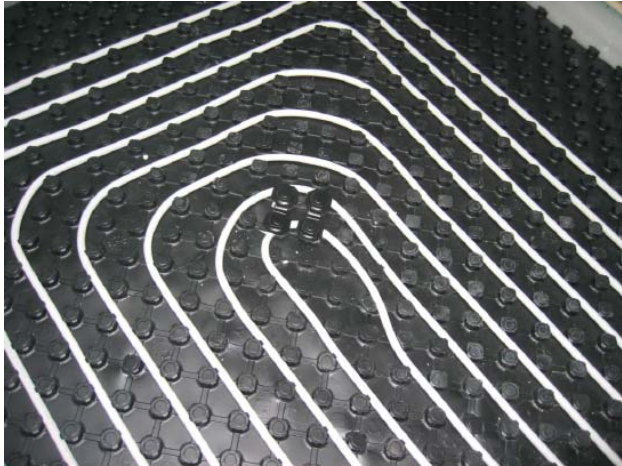
Панельное напольное отопление с системными элементами в виде мата с бобышками
