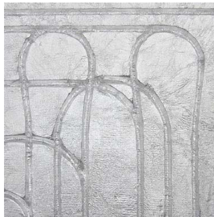
Элемент мультизажимной плиты для зоны разворота труб
