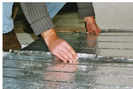
Укладка мультизажимных плит и склеивание фольгированной пленки внахлест
