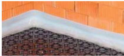
Пример укладки краевой ленты и крепления ее к стене
