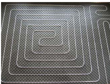
Бифилярная (улиткообразная) укладка с помощью матов с бобышками
