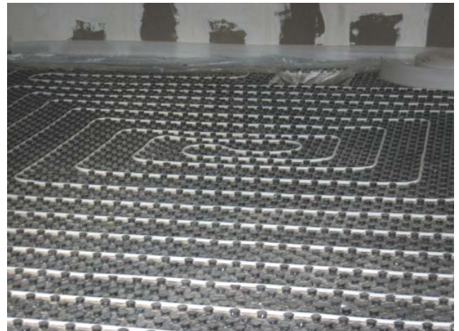
Спиралевидная укладка на матах с бобышками
