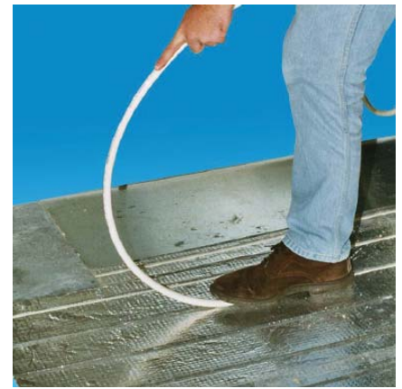
Вдавливание труб отопления
