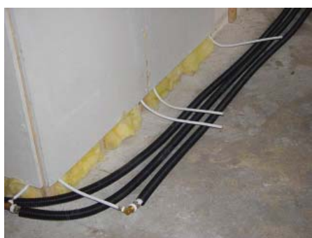
Подключение стеновых отопительных панелей
