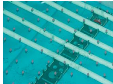
Краевая зона системы напольного отопления
