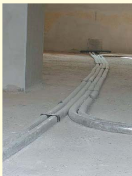
Пример: подключение от встраиваемых распределителей ГЕРЦ
