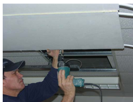
Монтаж потолочных охлаждающих панелей
