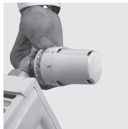
6. Поверните и установите блокирующие штифты напротив позиции «3».
