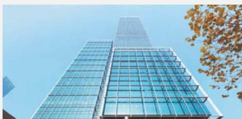
Многоэтажное здание без стилобата
