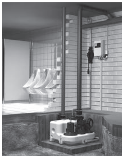
Рис. 94 Пример установки Multilift MD в приямок в подвальном помещении здания
