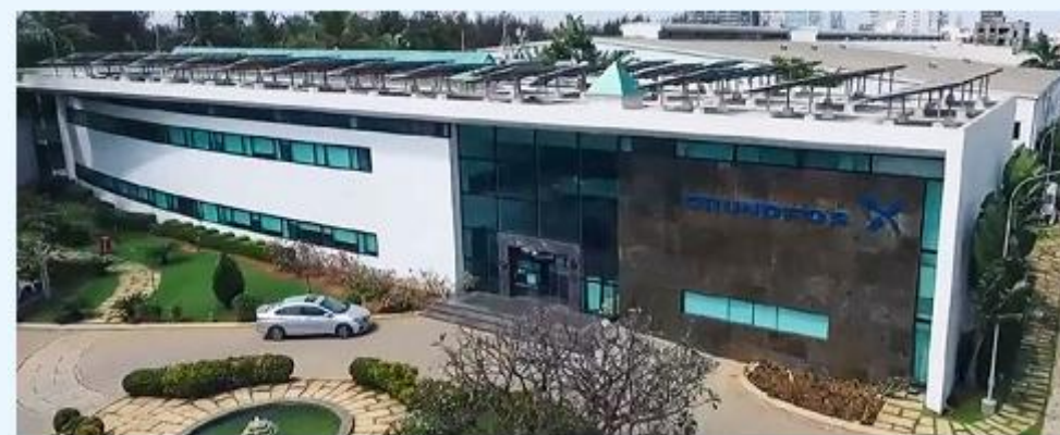
Наше здание в индийском городе Ченнаи получило сертификат LEED Platinum
