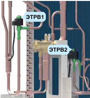
Электронный терморегулирующий вентиль — это один из четырех основных элементов кондиционера. Он регулирует расход хладагента, поступающего в испаритель. В наружном блоке используется два ТРВ: основной 3 000-ступенчатый ТРВ и 480-ступенчатый ТРВ переохладителя. Они обеспечивают максимально точный контроль расхода хладагента между наружными и внутренними блоками.
