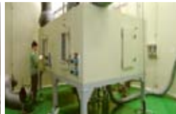
Испытание надежности и ресурса работы оборудования
