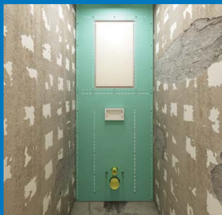
Установка сантехнического скрытого лючка для доступа к вентилям и счетчикам.
