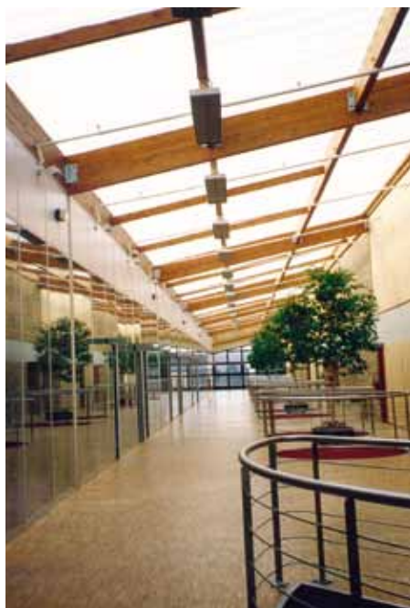
В коридорах часто бывает прохладно. Приборы EZ100 могут использоваться как дополнительный источник тепла.
