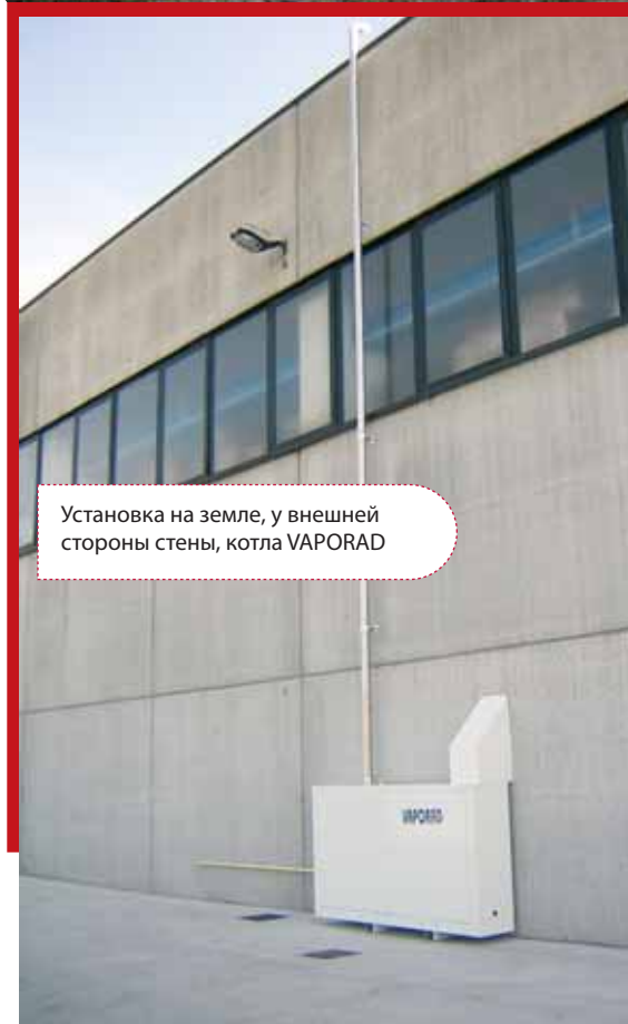
Установка на внешней стороне стены котла VAPORAD
