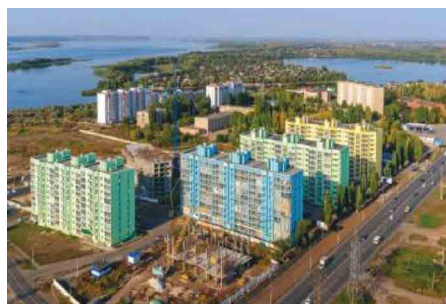
Объект: ЖК «Волжский изумруд», г. Энгельс Поставщик: ООО «Сантехкомплект»
