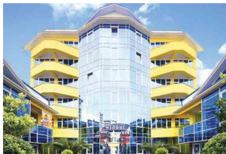
Объект: Гостиница «Атлант», г. Сочи Поставщик: ООО «Теплосервис»
