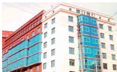
Объект: Жилое здание, г. Воронеж Поставщик: ПБЮЛ Сураев, «Евросантехника»
