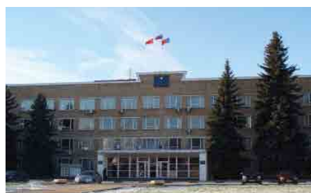
Объект: Здание администрации, г. Щелково Поставщик: ООО «Базис ТСС»
