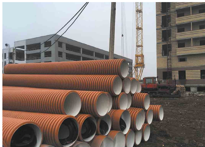
Объект: Жилой комплекс «Екатерининский», г. Ростов-на-Дону Подрядчик: ООО «Горстройснаб»
