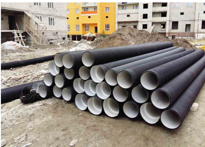
Объект: Жилой комплекс мкр. Среда, г. Пенза Подрядчик: ООО «РУСКОМПЛЕКТ»
