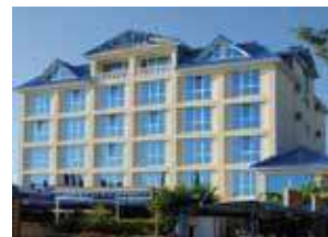
Объект: Гостиница «Оазис», г. Сочи Поставщик : ООО «Теплосервис»
