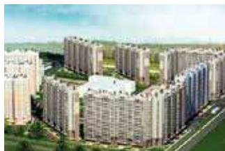
Объект: ЖК «Каменка», г. Санкт-Петербург, 78 квартал, мкр Каменка Поставщик : ООО «Денеб»
