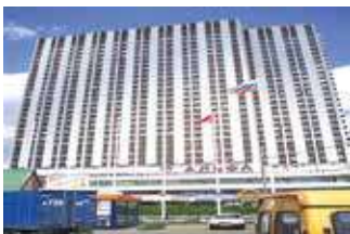
Объект: Гостиничный комплекс «Измайлово», г. Москва Поставщик : ООО «Полистальгрупп»
