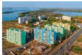
Объект: ЖК «Волжский изумруд», г. Энгельс, ул. Студенческая Поставщик : ООО «Сантехкомплект»
