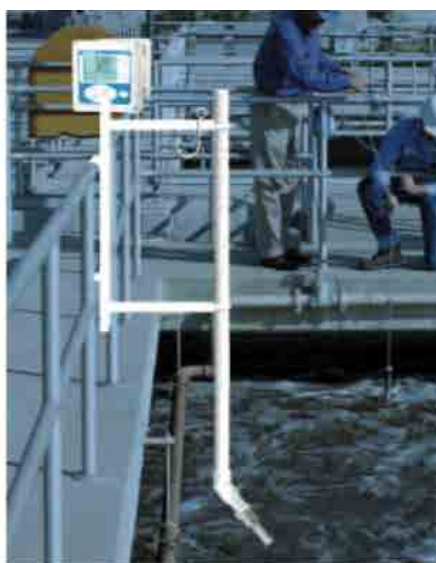
Рис. 8.2.17 Фотография слева показывает датчик, который был неправильно установлен в резервуаре
