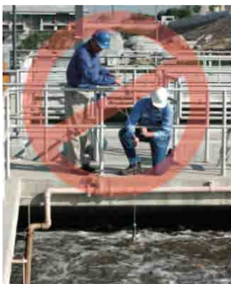
Рис. 8.2.17 Фотография слева показывает датчик, который был неправильно установлен в резервуаре
