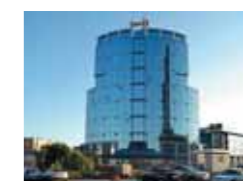
Здание дорожного центра управления перевозками РЖД г. Екатеринбург
