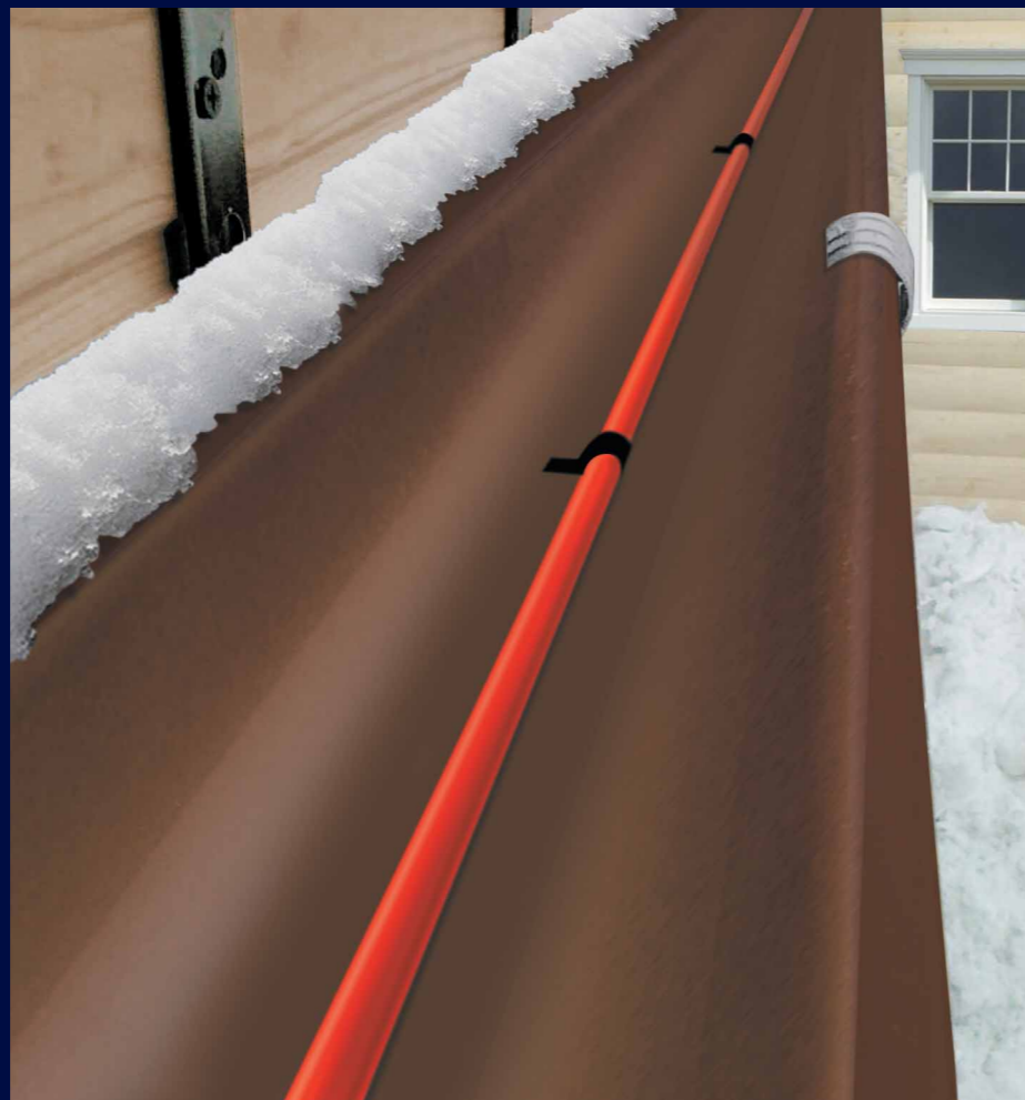
Вариант установки нагревательного кабеля в водосточных желобах
